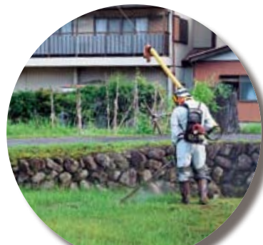
旧保育園跡整備
